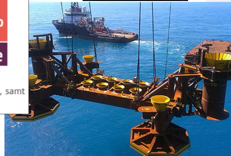
Forboringssrammen er 32 meter lang og 10 meter høy.
